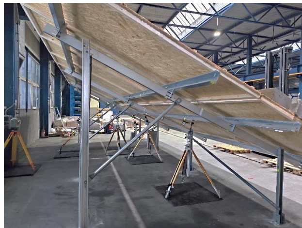
Rys. 3.6 Skanowanie 3D konstrukcji poddanej obciążeniu.
