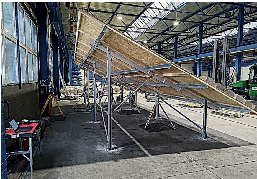
Fot. 1. Konstrukcja K-1
